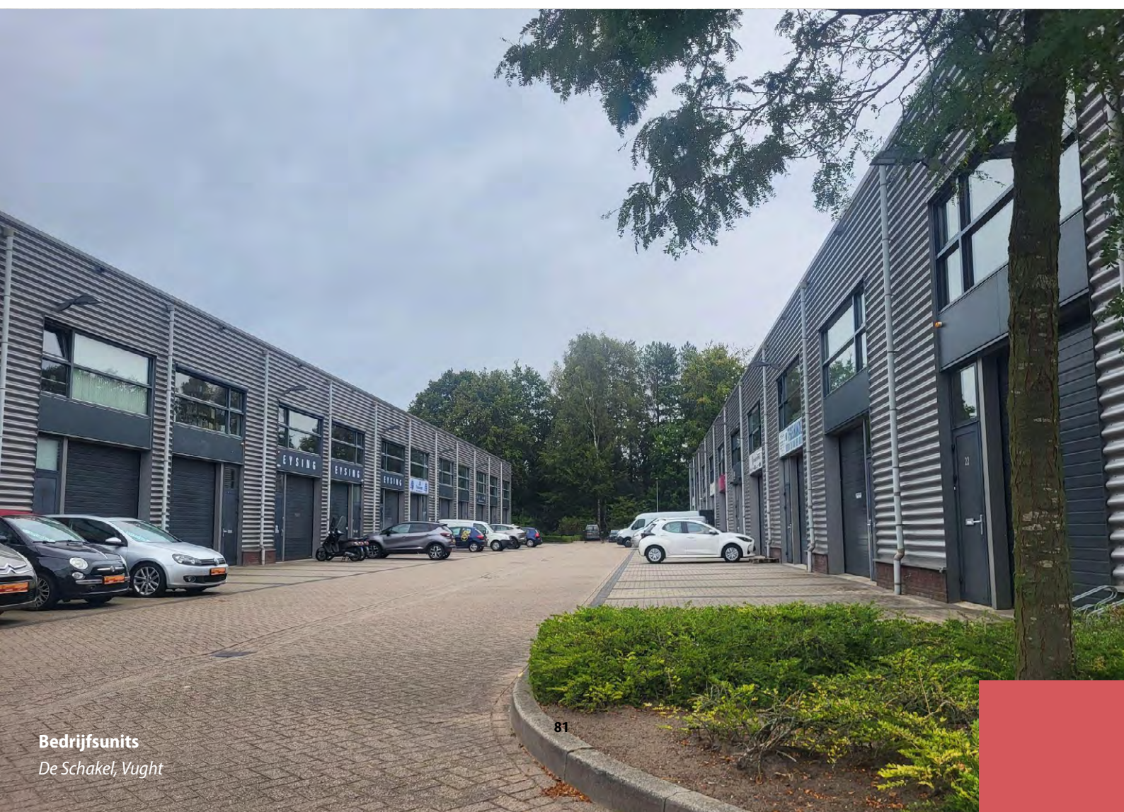
Bedrijfsunits Bargermeer, Emmen
